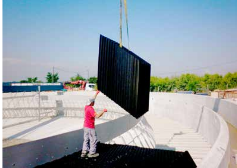
Son Çökeltim Havuzlarına Lamella Montajı
